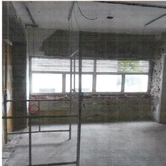
Foto 02 - Remoção de reboco deficiente.
