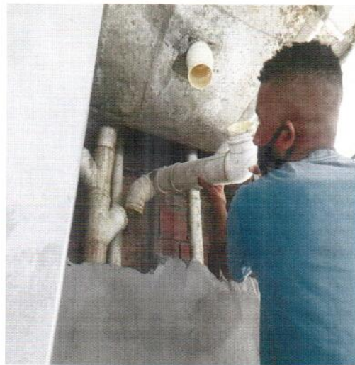
Foto 08 - Substituição das tubulações danificadas.
