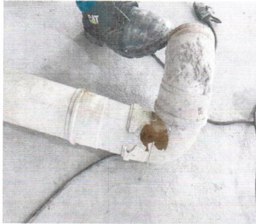
Foto 07 - Tubulações danificadas.
