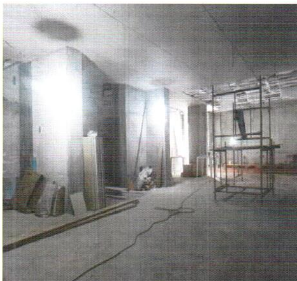
Foto 05 - Execução de forro extra para melhorar acústica.
