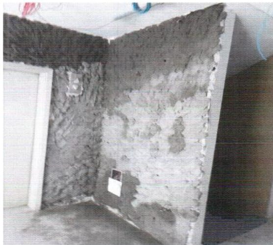
Foto 03 - Execução de novo reboco
