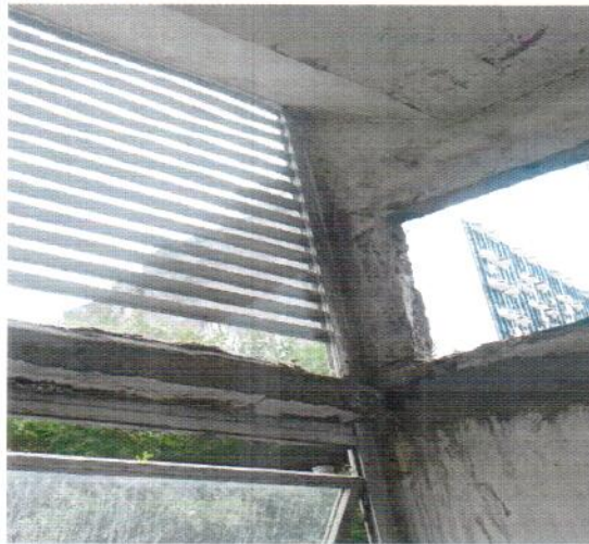
Foto 10 - Abertura que existia na fachada, foi realizado o fechamento com placas cimentícias.
