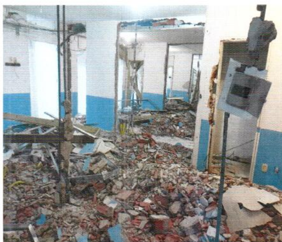
Foto 01 - Demolição de paredes para aumento da área de shaft.
